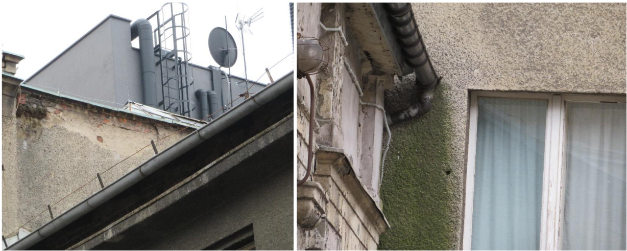
Przykłady destrukcji murszenia, odpadania i zamakania tynków na elewacjach
