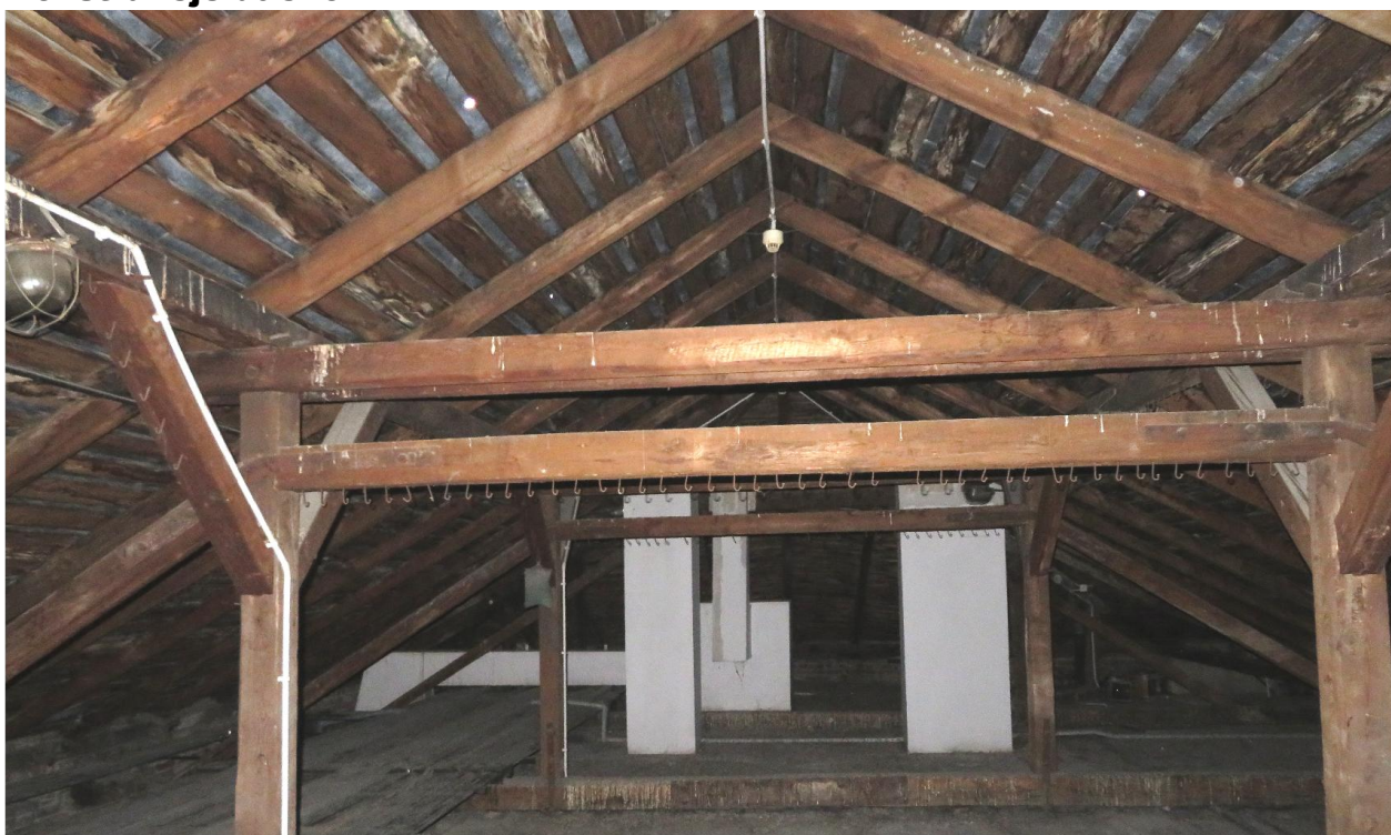
Więźba dachowa wieszarowa- bryła zasadnicza budynku -nad rekwizytornią i widownią
