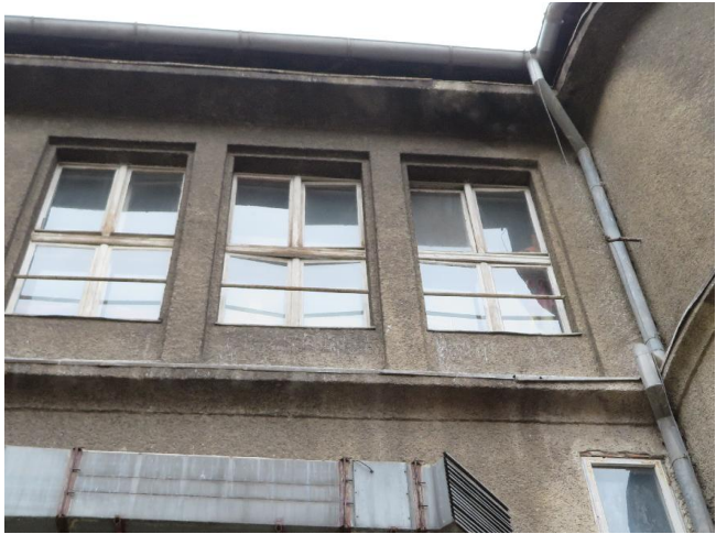
Stan techniczny stolarki zewnętrznej -mierny i niezadowolający
