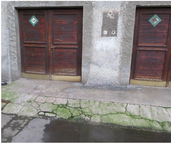
Stan techniczny stolarki zewnętrznej -mierny i niezadowolający
