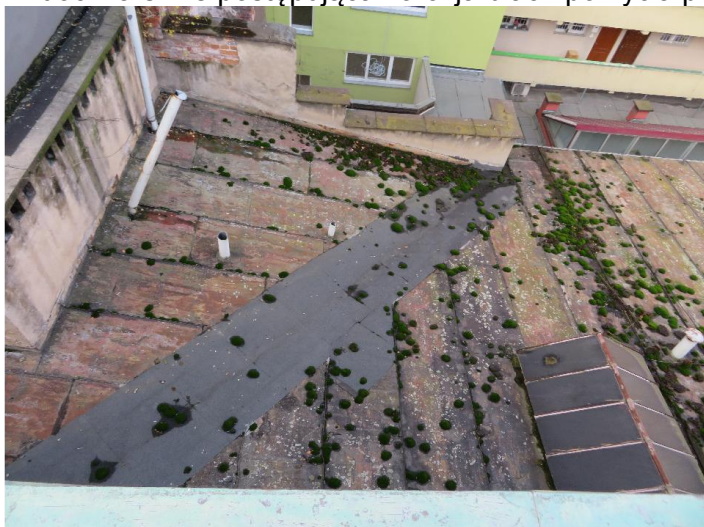
W rejonie świetlika star pokrycie papowe jest na znacznej powierzchni nieszczelne
