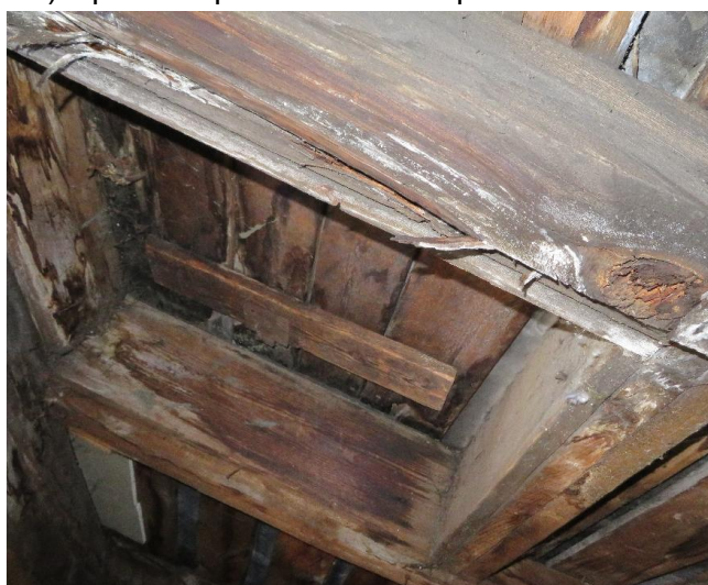
Murszenie elementów drewnianych ( deskowania) z powodu przecieków oraz przamarzania
