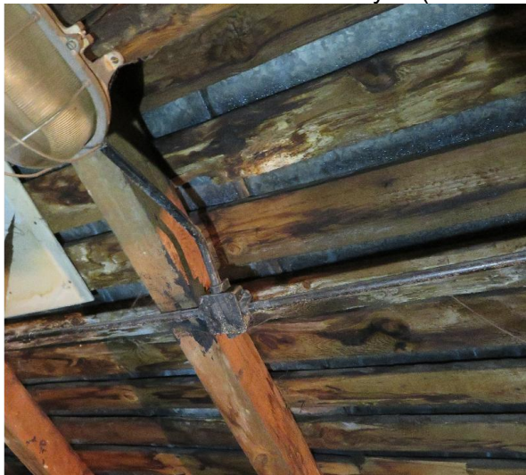
Murszenie elementów drewnianych ( deskowania) z powodu przecieków oraz przamarzania
