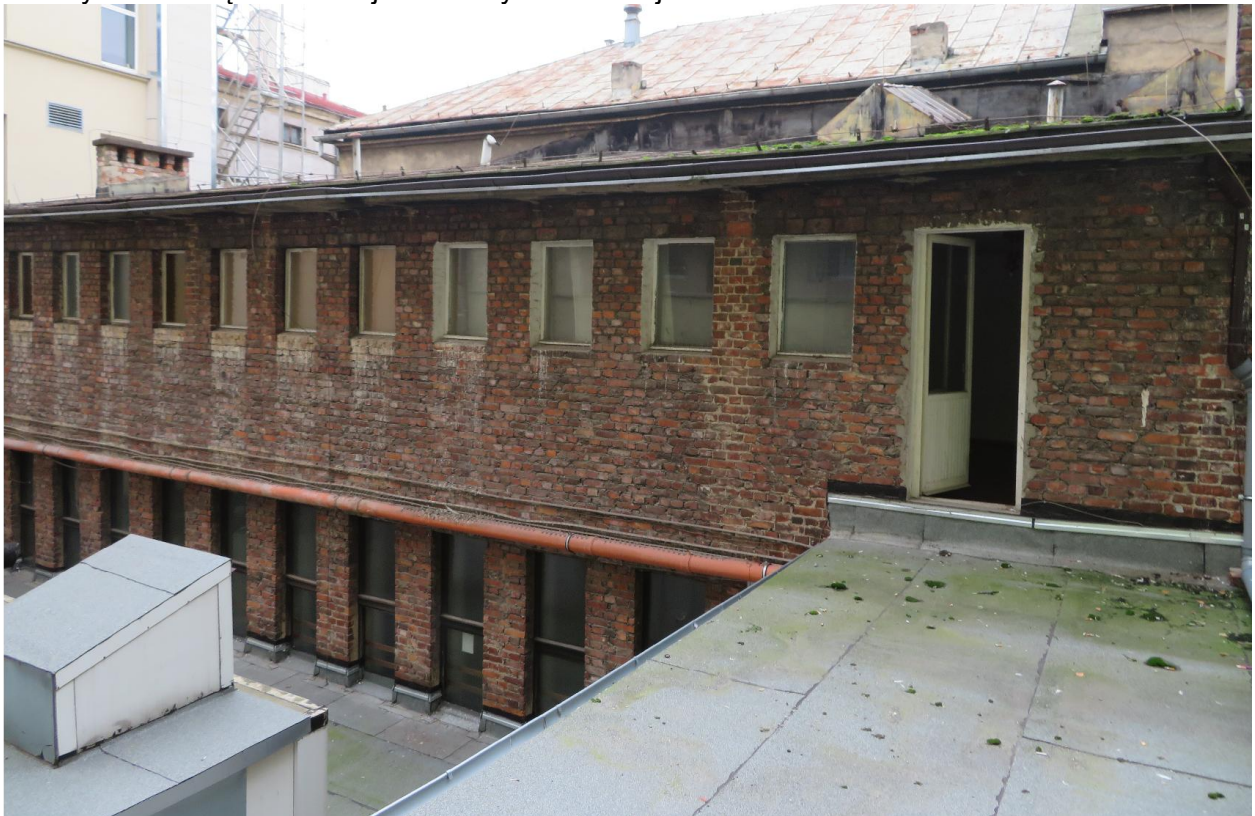
Brak tynku na części elewacji od strony zachodniej
