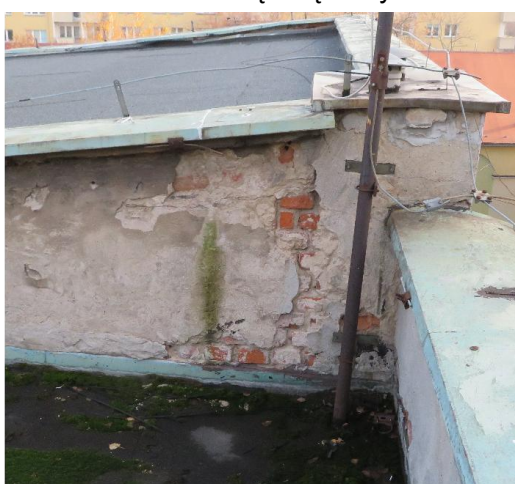
Nieszczelności na stykach połączeń z elementami pionowymi ( attykami, ogniomurkami itp..)
