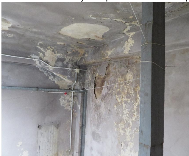
Skutki nieszczelności pokrycia – w rejonie dachu nad bud , mieszkalnym i klatce schodowej basztowej , poniżej zacieki w obrębie klatki schodowej bud. Mieszkalnego
