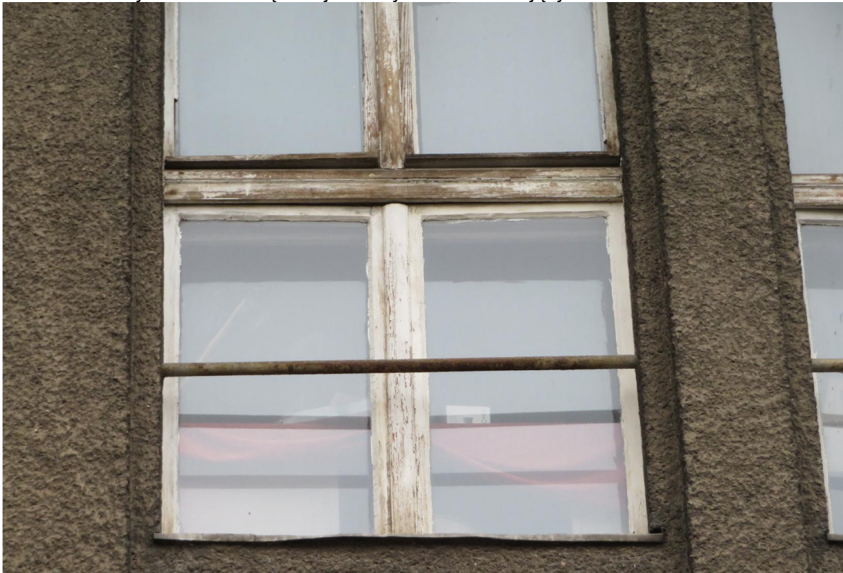
Stan techniczny stolarki zewnętrznej -mierny i niezadowolający
