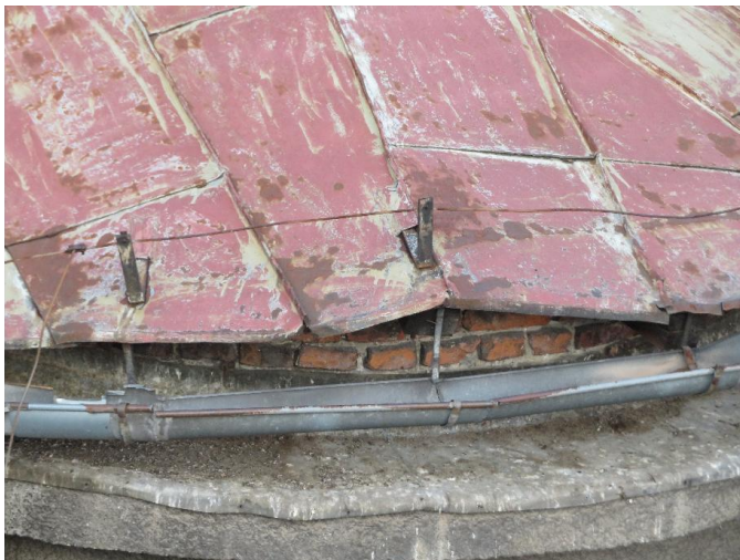
Widoczna silnie postępująca korozja blach pokrycia połaci dachowych
