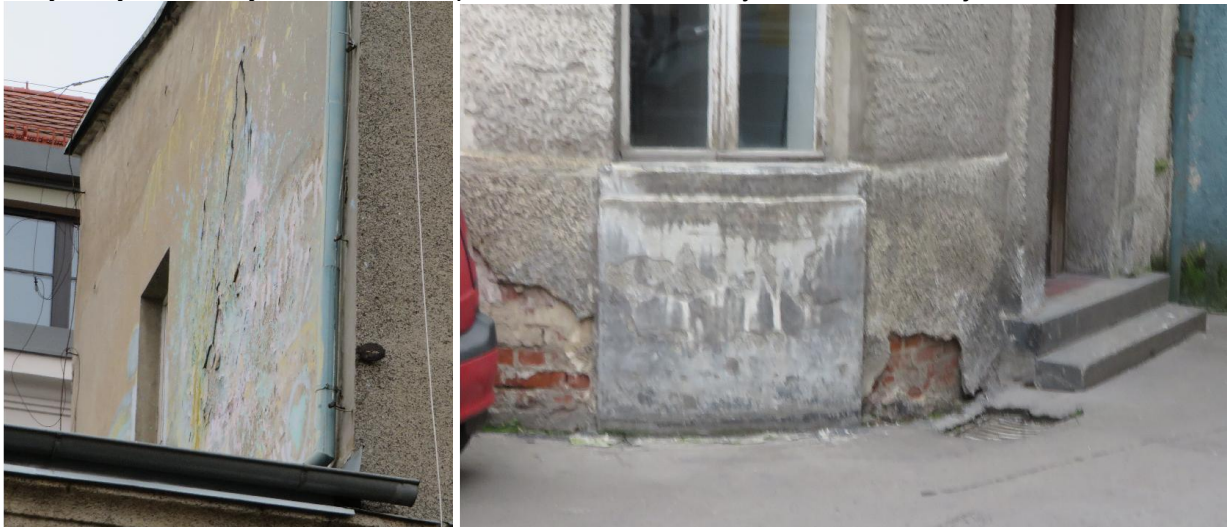
Brak tynku na części elewacji od strony zachodniej
