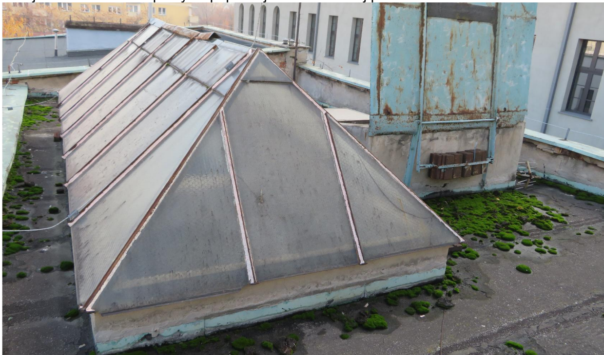
Widoczne mych i porosty świadczą o braku konserwacji pokrycia papowego oraz o stałym zaleganiu wody podczas opadów atmosferycznych
