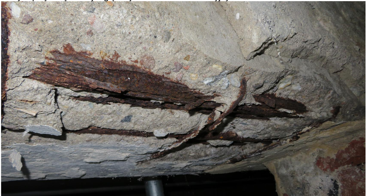
Kolejne przykłady korozji wgłębnej elementów konstrukcyjnych
