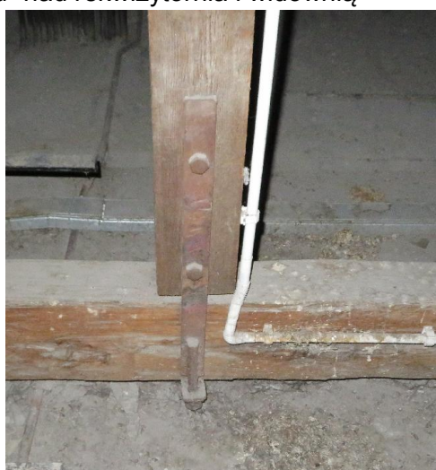
Murszenie elementów drewnianych ( deskowania) z powodu przecieków oraz przamarzania
