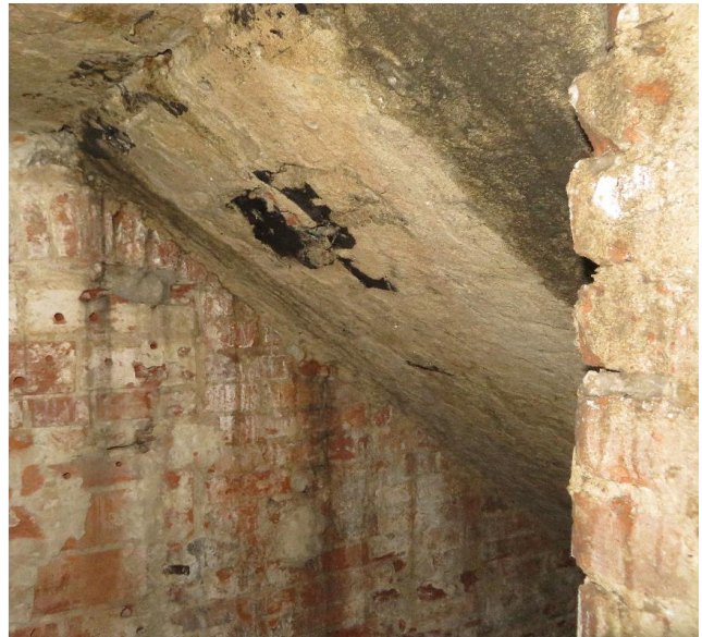
Piwnice w części budynku po widownię , silne zawilgocenie , zacieki , wykwyty solne , korozja wgłębna elementów stalowych
