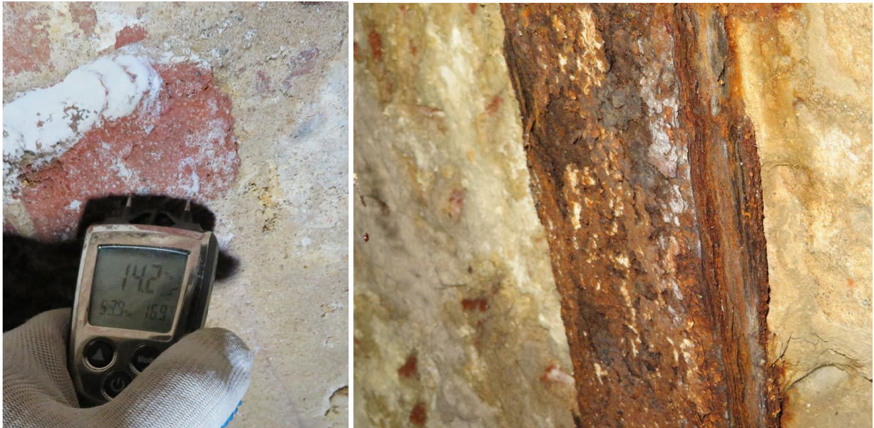
Kolejne przykłady korozji wgłębnej elementów konstrukcyjnych
