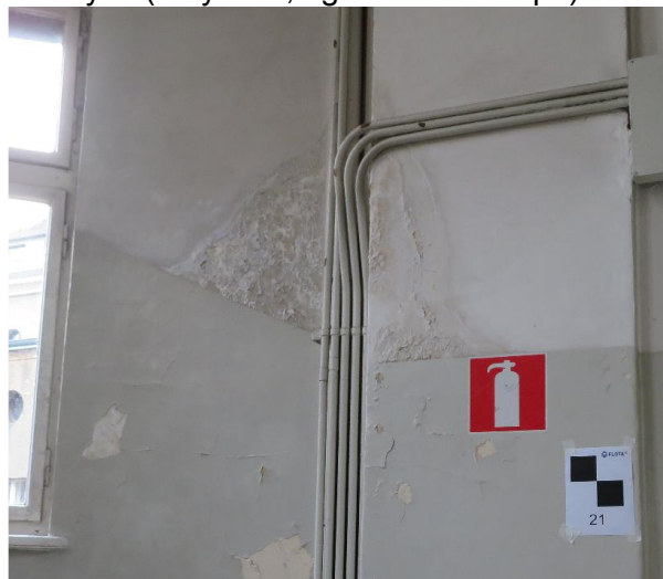
Skutki nieszczelności pokrycia – w rejonie dachu nad bud , mieszkalnym i klatce schodowej basztowej , poniżej zacieki w obrębie klatki schodowej bud. Mieszkalnego
