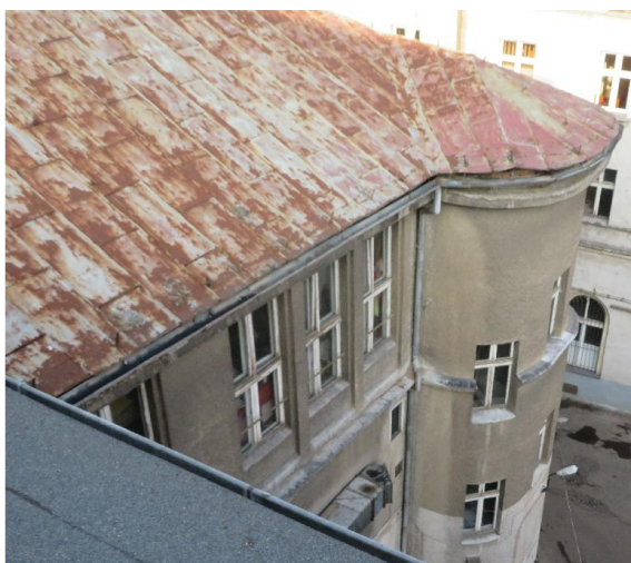
Widoczna silnie postępująca korozja blach pokrycia połaci dachowych
