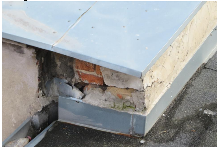
Nieszczelności na stykach połączeń z elementami pionowymi ( attykami, ogniomurkami itp..)
