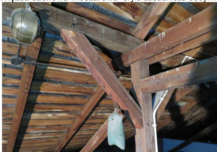
Murszenie elementów drewnianych ( deskowania) z powodu przecieków oraz przamarzania
