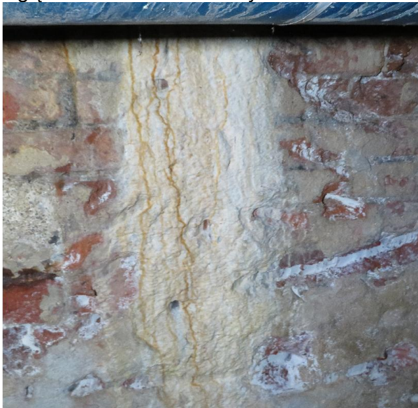
Piwnice w części budynku po widownię , silne zawilgocenie , zacieki , wykwyty solne , korozja wgłębna elementów stalowych
